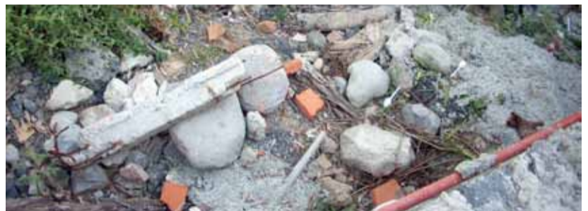
Residuos de manejo especial de obra en la Zona de Amortiguamiento A2
