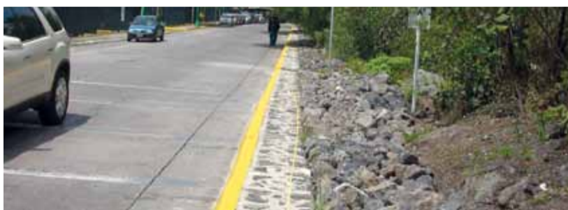
Impacto de construcción de camellón e infraestructura para tensión media en la Zona de Amortiguamiento A8 y aspecto terminado de la obra.
