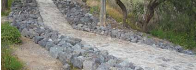
Mamostería como medida de mitigación del andador ubicado en la Zona de Amortiguamiento A8.
