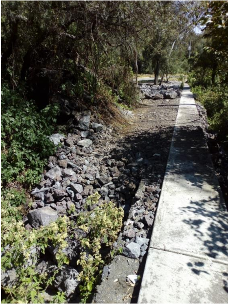
Figura 37. Pedregal 13 relleno con roca volcánica.
