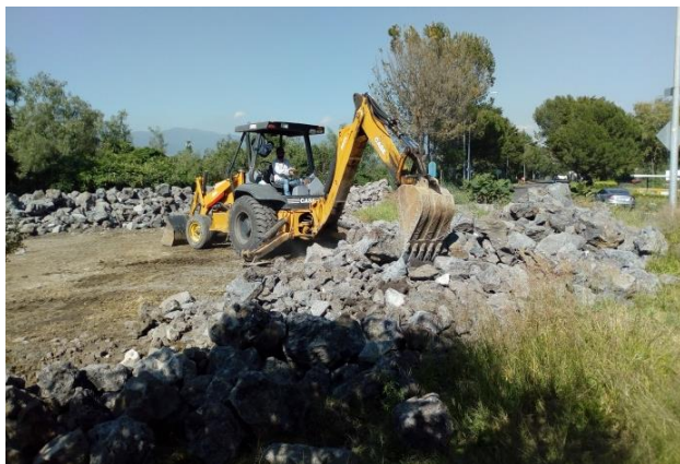
Figura 35. Acomodo de roca con retroexcavadora.
