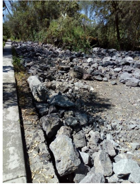
Figura 38. Se observa la colocación de sustrato donde probablemente crecerán malezas.
