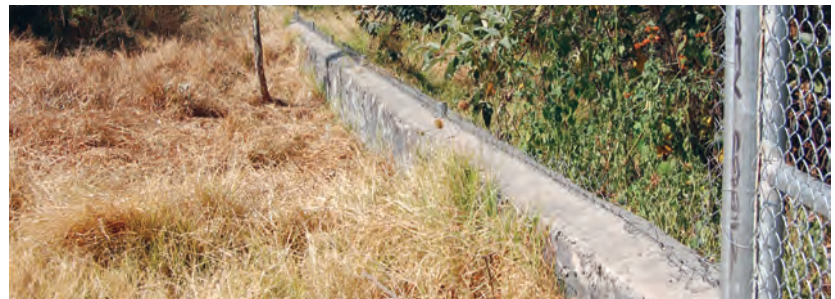
Robo de malla ciclónica del perímetro de la Zona Núcleo Sur Oriente.
