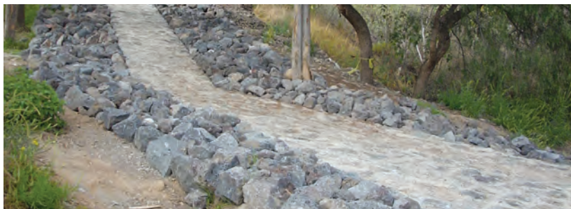
Mampostería como medida de mitigación del andador ubicado en la Zona de Amortiguamiento A8.
