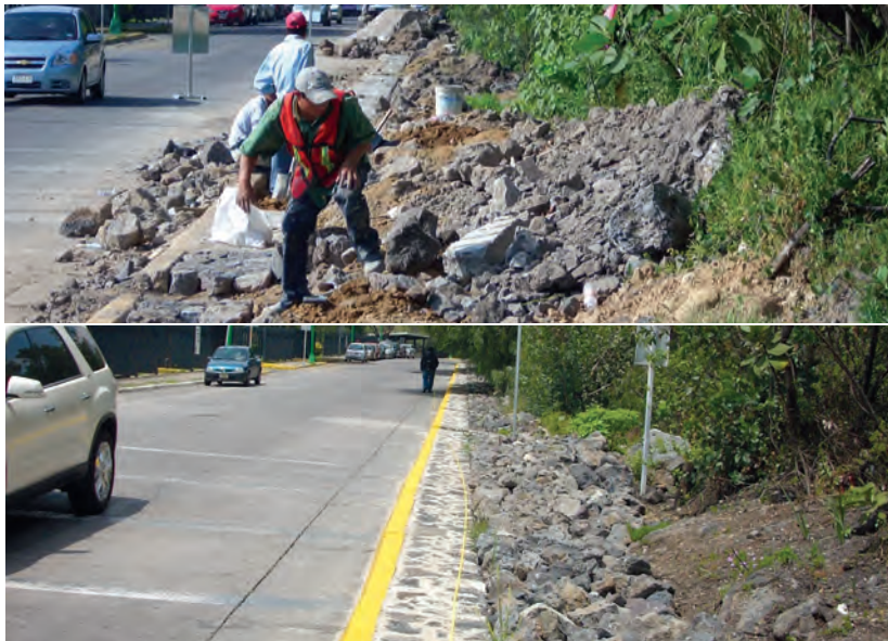
Impacto de construcción de camellón e infraestructura para tensión media en la Zona de Amortiguamiento A8 y aspecto terminado de la obra.
